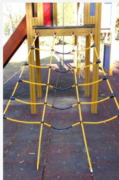
Rete trapezoidale realizzata con fune Erkules  $\varnothing$  16 mm.
